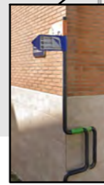
Re-vinilat i recol·locació senyal vertical
